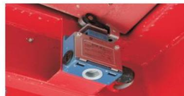
笼顶紧急出口电气开关
