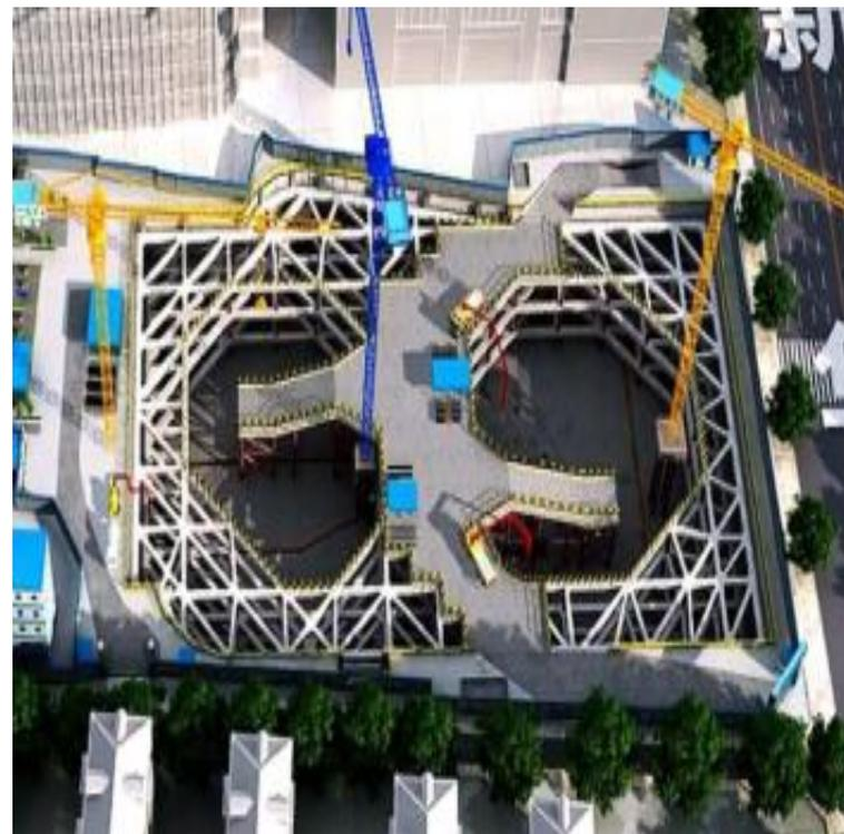
钢筋混凝土支撑示意图
